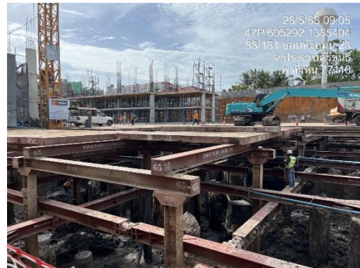
รูปที่ 42 ระบบค้ำยันเหล็ก (Bracing)
