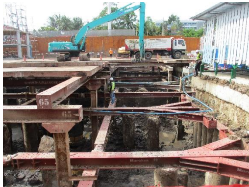
รูปที่ 42 ระบบค้ำยันเหล็ก (Bracing)
